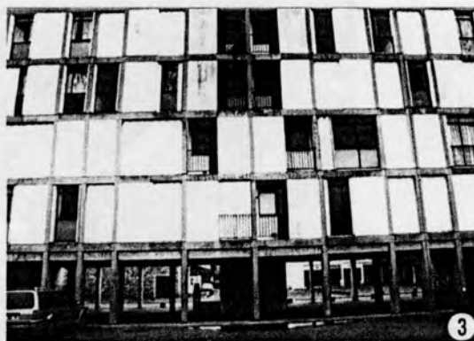
3 - Avant / 4 - Après : grâce à des démolitions sélectives, la vue s'étend désormais depuis l'intérieur de la place jusqu'au marché couvert et l'avenue principale.
