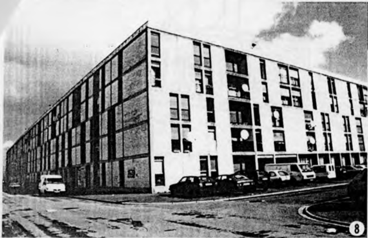
8 - Avant / 9 - Après (photo du bas) : l'ouverture faite aux angles supprime le caractère de forteresse, et indique désormais au visiteur le caractère enviable de l'aménagement intérieur plante.
